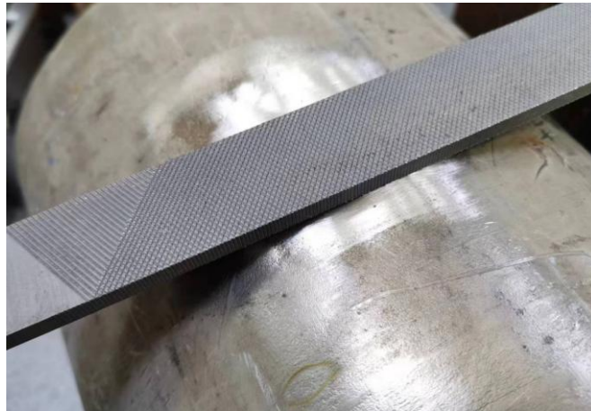
图 10. 安装点表面打磨
