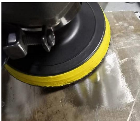
图 5. 安装点表面处理
