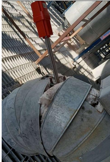
图 17.2. 保温层的处理，在夹板处要保留散热空间
